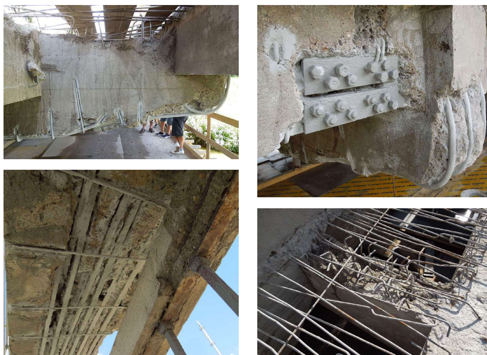
Obr. 3 Vybrané detaily konstrukce po obnažení (zleva doprava - koncová oblast příčnicku, stykávání ocelových plechů táhla oblouku, výztuž oblouku, výztužení původního chodníku a příčnicku)
